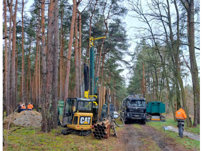
Abb. 33: Bau eines geförderten Löschbrunnens im Wald (Foto: R. Engel)
